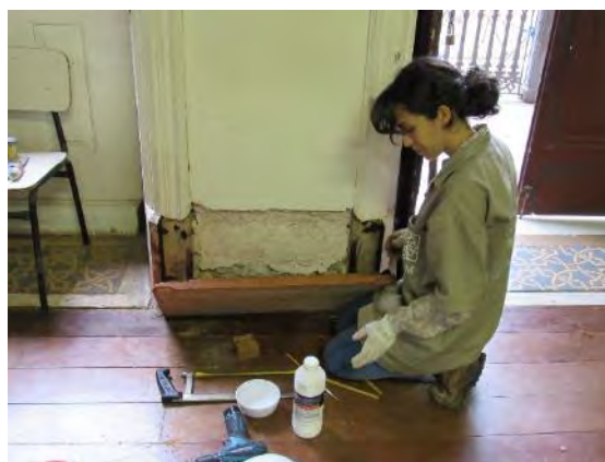
Figura 77: Autora como aluna da OEM em execução de recuperação de rodapé. Fonte: Camila Ennes.
