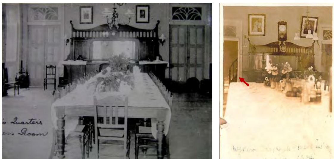
Figura 32 (acima, esquerda): Fotografia intitulada como [M]ess Room (provavelmente “Mess”). O modelo de janela, na lateral, é o mesmo observado nas esquadrias do Chalé até hoje, com exceção da perda das almofadas inferiores, observada na maior parte dos elementos atualmente. Fonte: Inepac (1977), fornecida pela família de Mr. Bennet, engenheiro responsável pela implantação da companhia na época. A Figura 33 (acima, direita) mostra a mesma composição da imagem anterior, podendo ser observado, no entanto, o início a escada que provavelmente levava ao segundo pavimento do Chalé (destaque). Fonte: Imagens cedidas por Richard Kelynack Cocks à EAU-UFF em 1990. Fornecidas à autora pelo Prof. José Pessoa. Não foi possível, no entanto, definir com precisão a localização da fotografia dentro do edifício, hoje.
