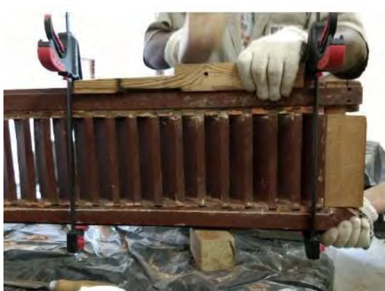
Figura 79: Execução de recuperação de folha de veneziana de janela do Casarão. Fonte: Dulce A. Keuchkarian
