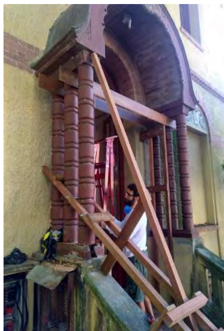
Figura 81: Escoramento e recuperação de base de pórtico lateral, junho de 2018. Fonte: Camila Ennes
