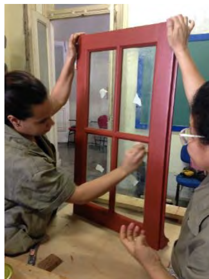
Figuras 176: Folha de esquadria ao final de intervenção, após pintura, no primeiro semestre de 2018, pelos alunos da OEM/COC/Fiocruz. Fonte: Ronaldo Brillhante
