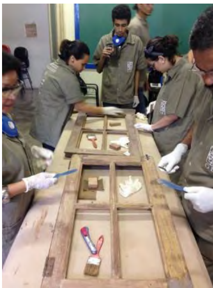
Figuras 175: Intervenção em folhas de esquadria em andamento no primeiro semestre de 2018, pelos alunos da OEM/COC/Fiocruz. Fonte: Ronaldo Brillhante
