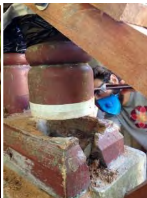
Figuras 186 e 187: Base durante intervenções e aspecto da seção da coluna retirada. Fonte: Ronaldo Brilhante.
