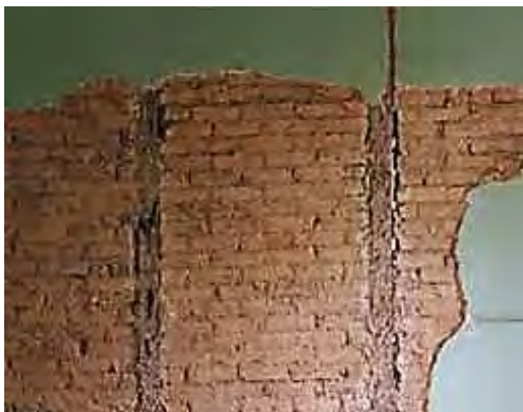
Figura 127: Fotografia de alvenaria do Solar do Jambeiro durante obra de restauração. Fonte: https://culturaniteroi.com.br/blog/?id=202 , acesso em 18 de outubro de 2019.
