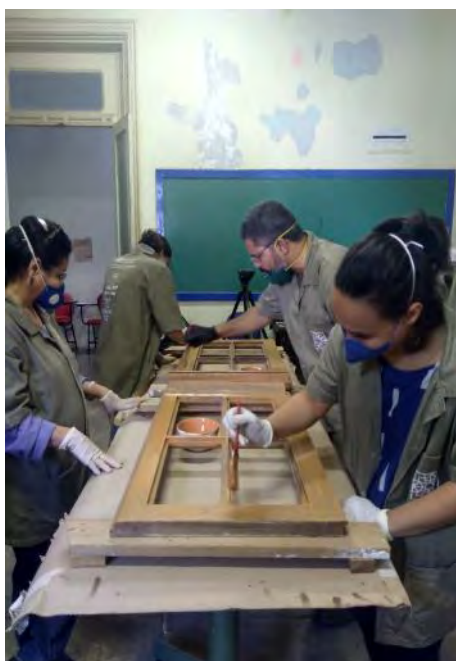
Figura 80: Recuperação de esquadrias do sótão, junho de 2018. Fonte: Camila Ennes
