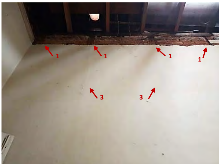
Figura 126: Esteios e alterações na parede em sua direção (3), em outubro de 2019. Fonte: Camila Ennes
