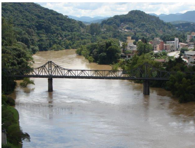
Figura 16 - Ponte da Estrada de Ferro, Rio Itajaí Açu, Blumenau-SC.
