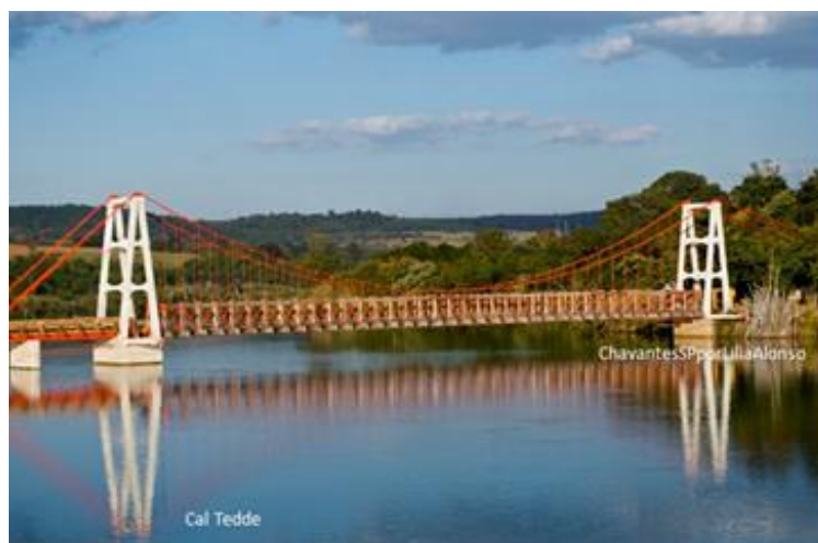
Figura 4 - Ponte Alves Lima, sobre o rio Paranapanema, SP-PR.
