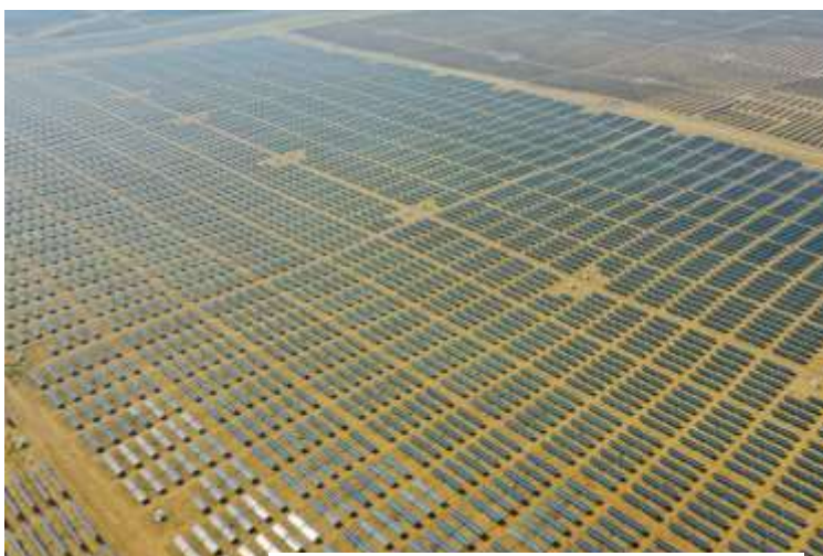
Fazenda de energia solar no deserto de Kubuqi, na região autônoma da Mongólia Interior na China. Foto: Xinhua. Fonte: https://www.scmp.com/news/china/science/article/3152240/chinas-clean-energy-push-targets-sandy-rocky-reaches-solar-and
