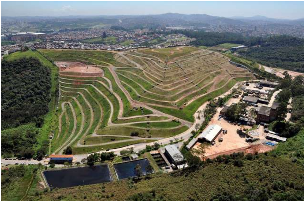
Figura 4. Registro da Área do Aterro Sanitário, em Samambaia, DF.
