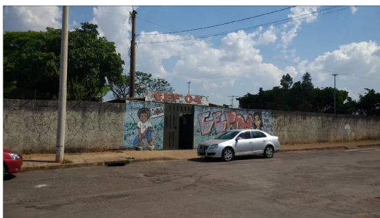
Figura 1: Centro de Ensino Fundamental 04 de Ceilândia
