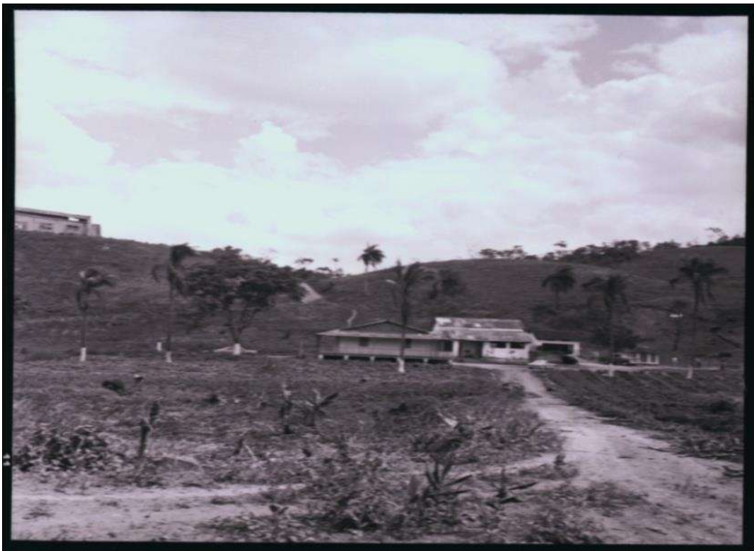
Figura 7: Única casa encontrada no terreno, pertencente à fazenda adquirida pelo Governo do Estado do Rio, 1972. A casa foi preservada e ainda existe. No alto da colina, as ruínas da fábrica de azulejos. Fonte: BR RJAPERJ AID.RP.PM.768-05
