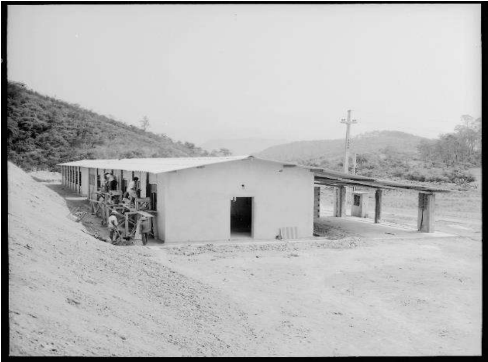
11. Construção de alojamento na Colônia. Magé (RJ). [1971-1975]. BR RJAPERJ AID.RP.CA.1732-11
