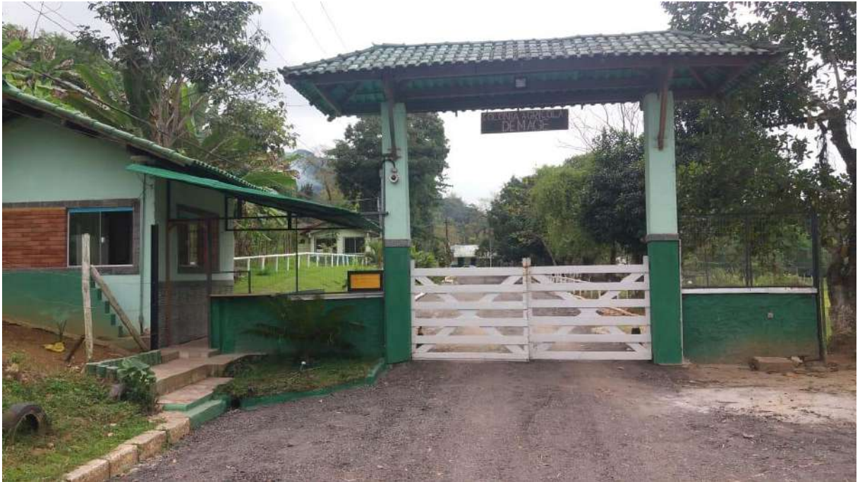
Figura 4: Portaria atual de acesso à Colônia Agrícola Penal de Magé.
