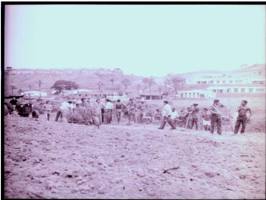
17. Registro das obras. Magé (RJ). [1975-1979]. BR RJAPERJ AID.FL.CA.15-28
