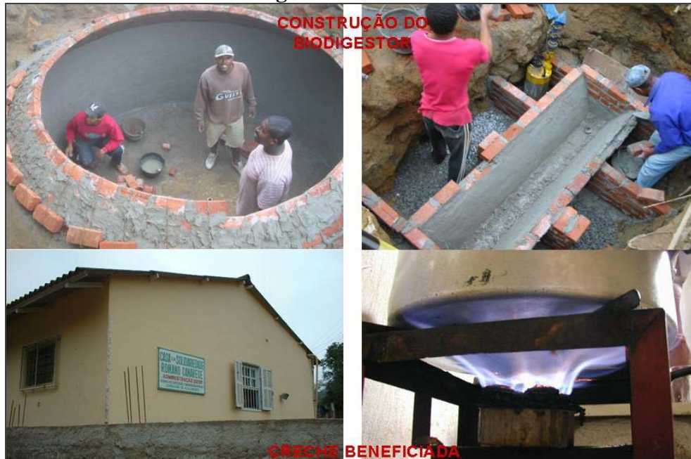
FIGURA 22: Foto da Construção dos Biodigestores Modelo Chinês em Creche Beneficiada com Biogás
