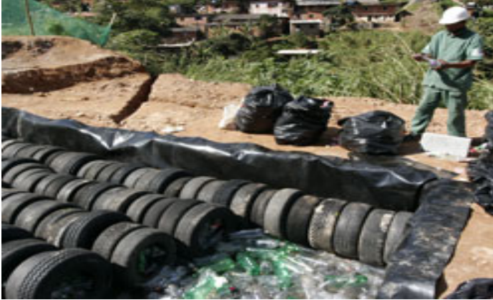
FIGURA 20: Filtro Anaeróbio Construído em Vila Ipanema Petrópolis- RJ, Utilizando como Meio Suporte Garrafas PET e Pneus Recolhidos pela COMDEP
