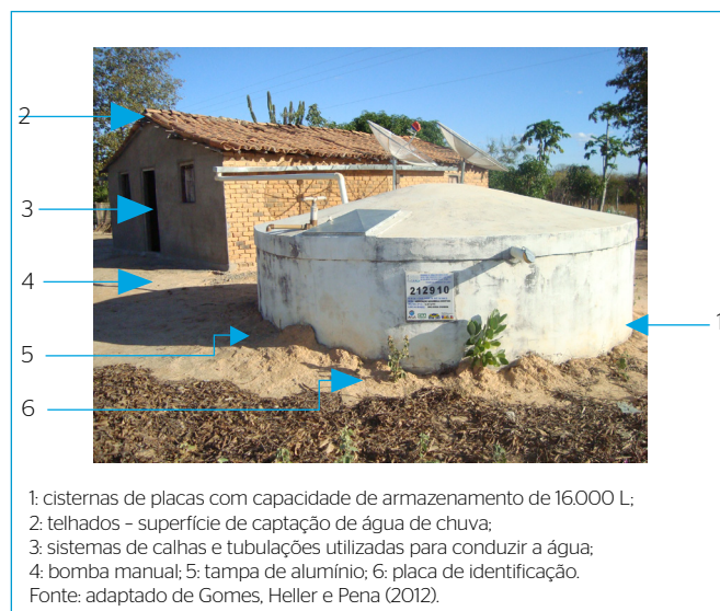
Figura 1 - Componentes do sistema de aproveitamento de água de chuva construído pelo Programa Um Milhão de Cisternas.
