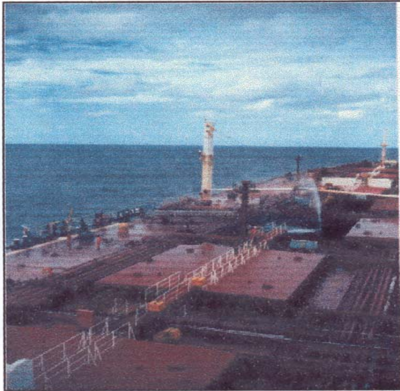
Foto 11 - Máquinas fixas de limpeza (com giro de 360° no bico e no corpo) em operação no porão nº 3.
