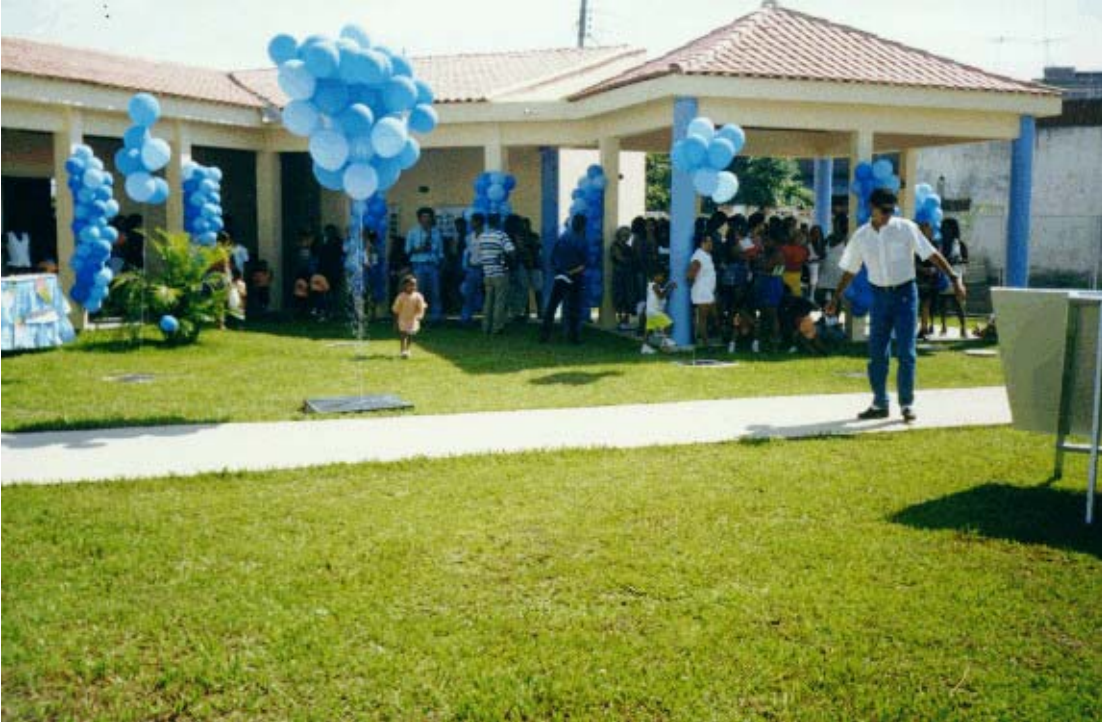
Creche construída em Sapucaia pelo Projeto Bairrinho, da SMH.
