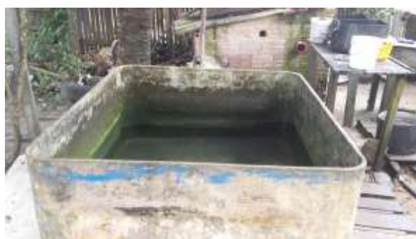
Foto 2: Abastecimento de água na Comunidade Maicá.
