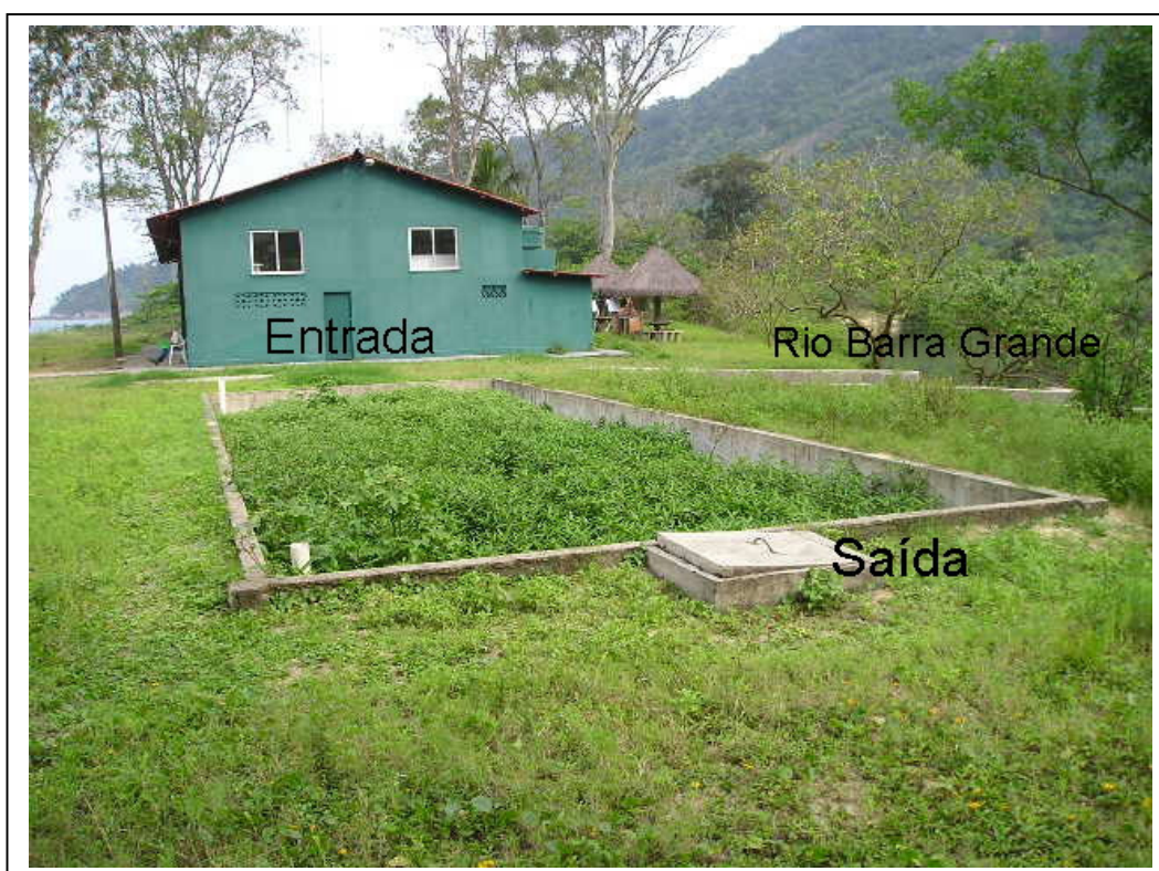
Figura 5: Visão do Sistema de Zona de Raízes do CEADS, e os pontos de coleta na entrada e saída do sistema (F.Kaczala).
