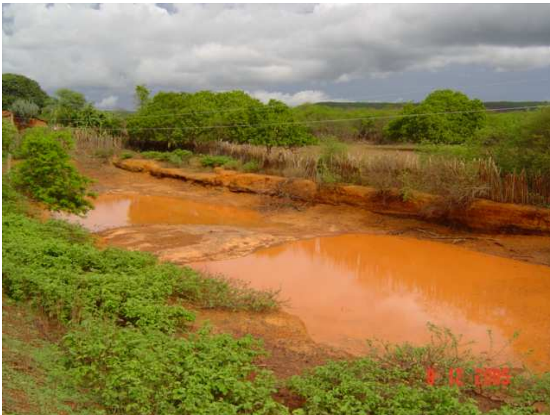
Foto 28: Açude do Empreste – Capelinha, município de João Costa (Foto: Rita Nunes)
