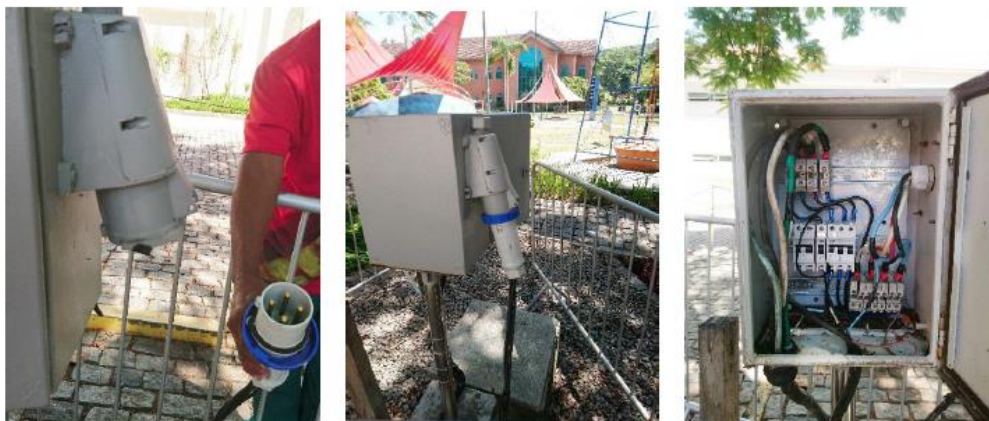
Foto: conexão do cabo elétrico do caminhão com a rede elétrica local.
