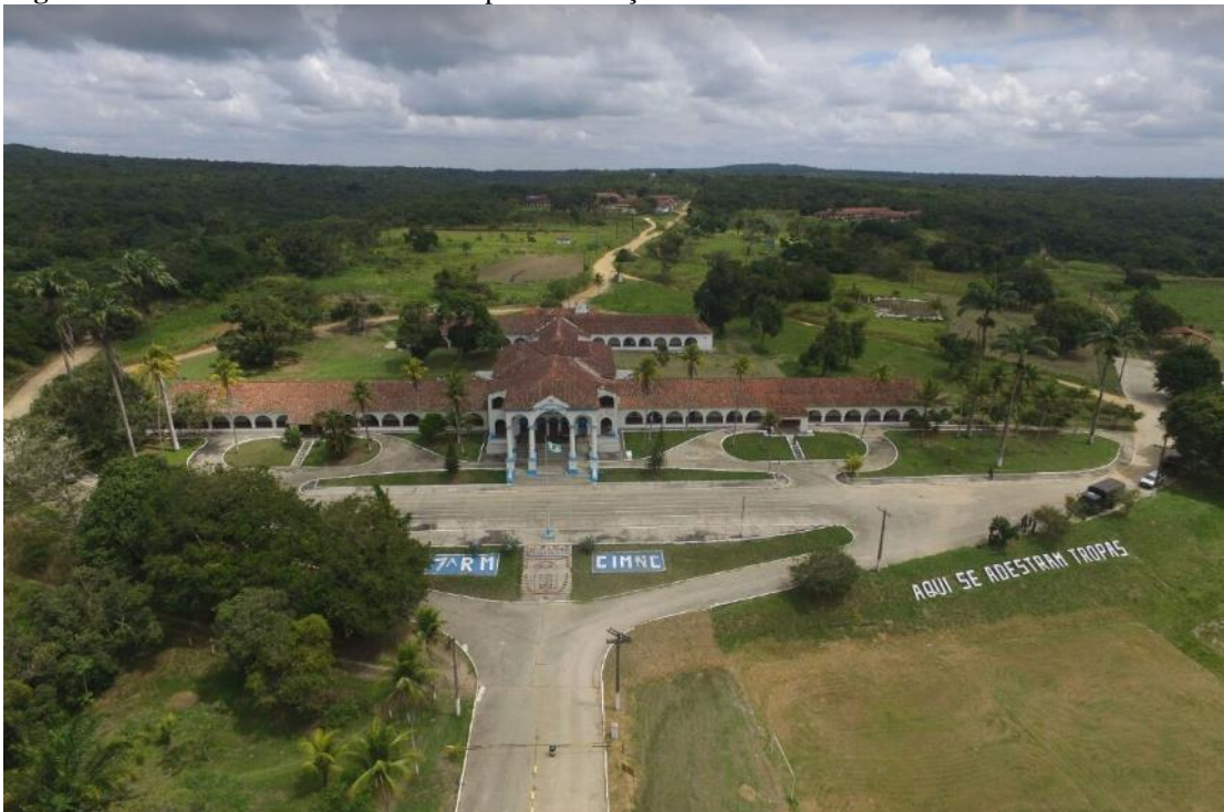
Figura 14 – Vista aérea da sede do Campo de Instrução Militar Marechal Newton Cavalcanti.
