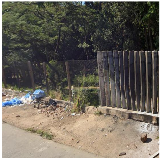
FIGURA 13 - Buraco na tela de alambrado nos fundos do parque.
