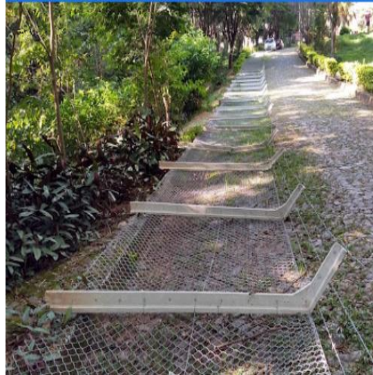
FIGURA 10 - Rua interna do Parque Professor Guilherme Lage com cerca caída
