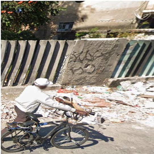
FIGURA 12 - Porta dos fundos do parque tampada por alvenaria
