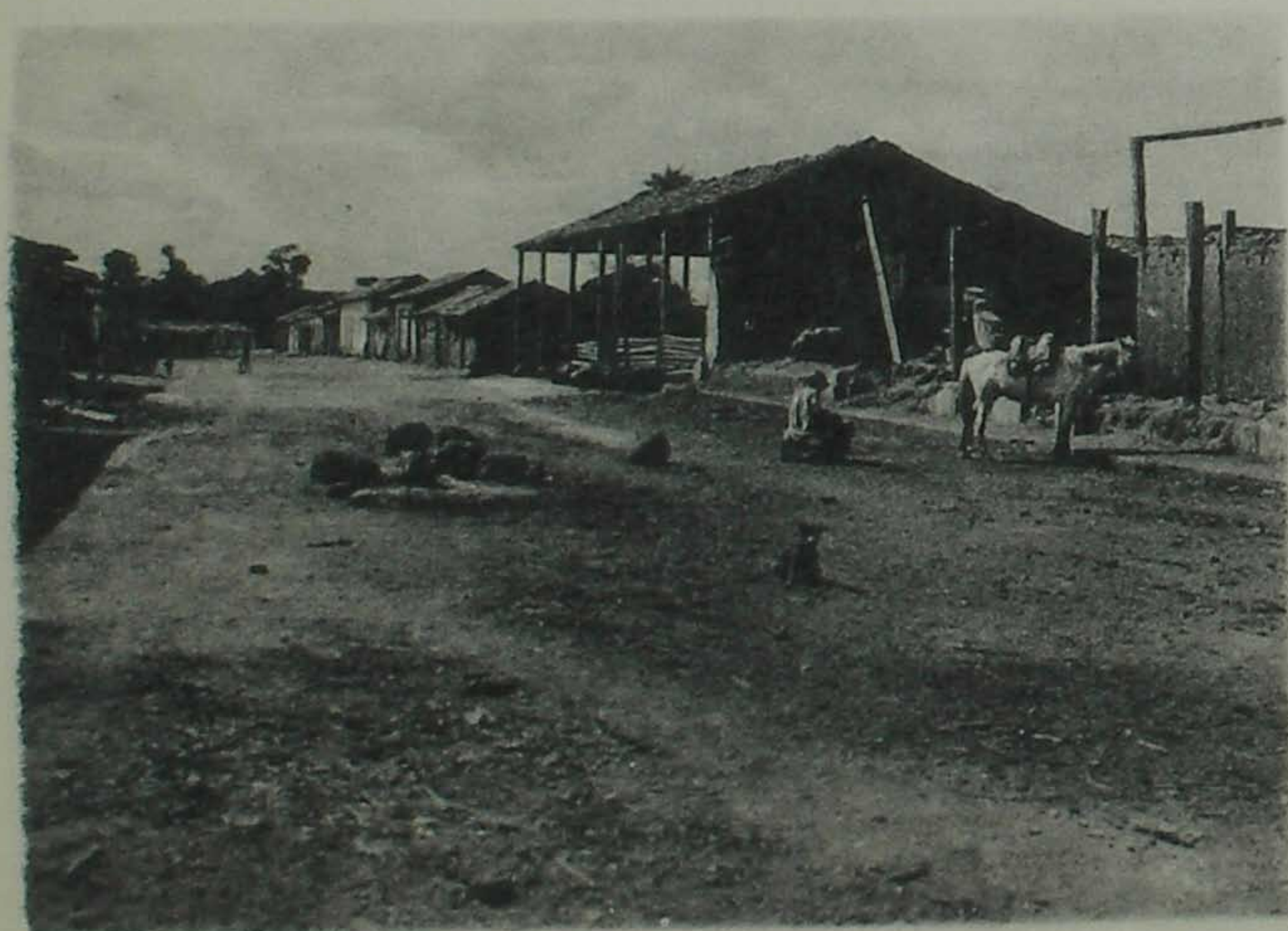
40—Formoza—Município de Santa Rita do Rio Preto—Bahia. Rua principal mostrando vestíjios das depredações ocasionadas por ocasião das lutas entre 2 chefes locais.
