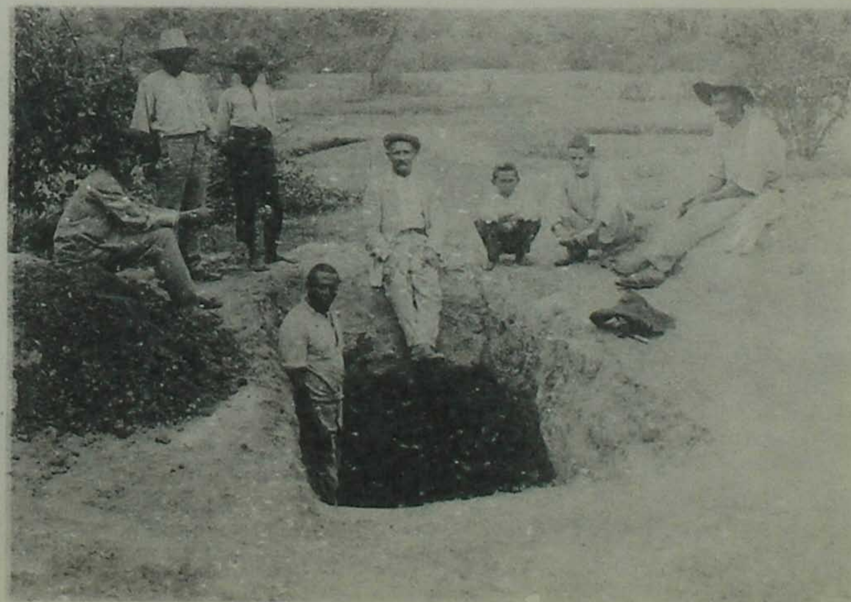
87—Camaradas em trabalho de abertura de cacimba para prover de água o acampamento. Município de Parnaguá—Piauí.
