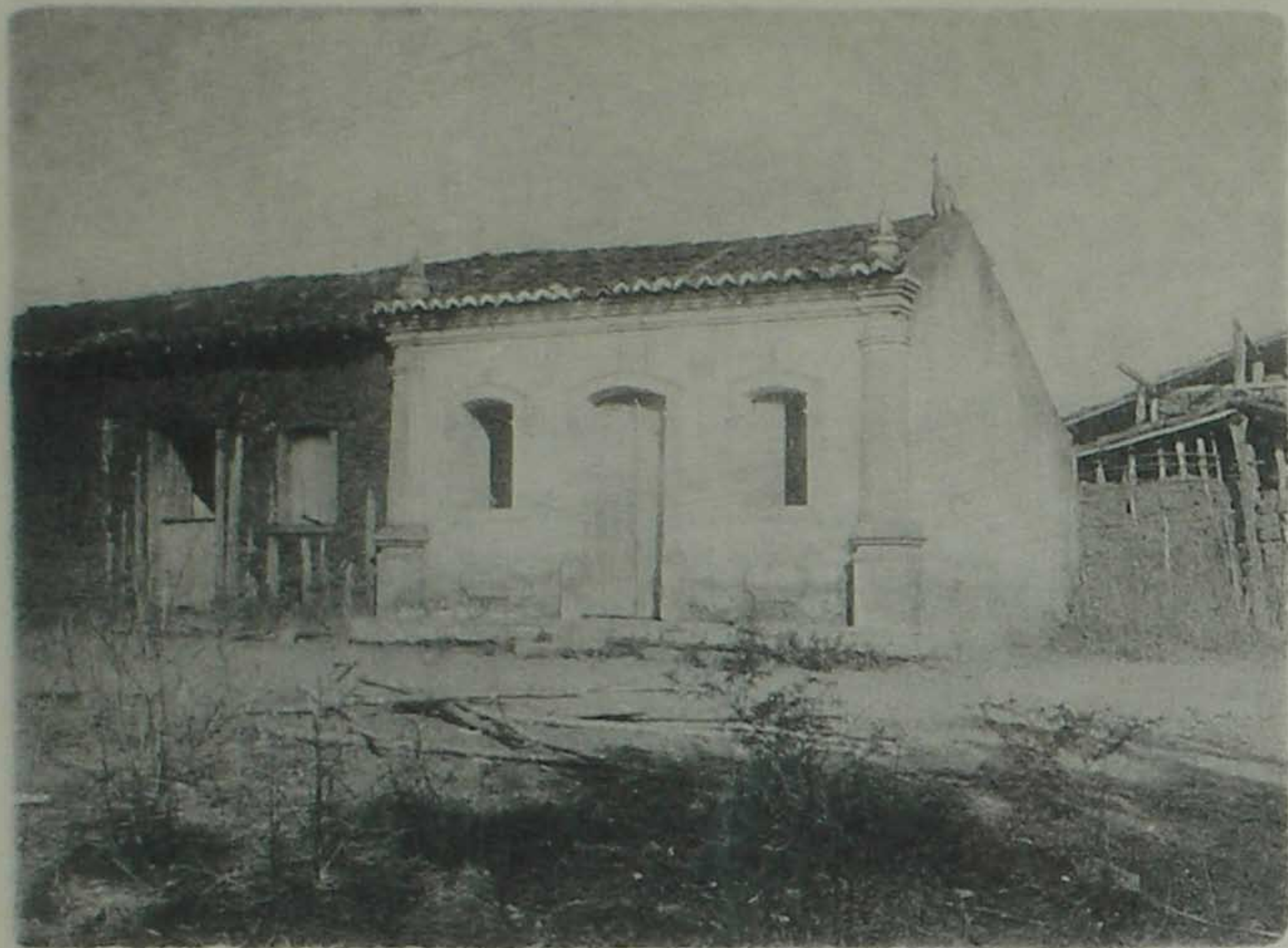
34—Trecho de uma rua em Caracól—Piauí, onde se vê uma casa caiada, demonstrando veleidades arquitetônicas, preocupações essas de todo inexistentes por ali. O tipo comum de habitação é o que se vê junto.
