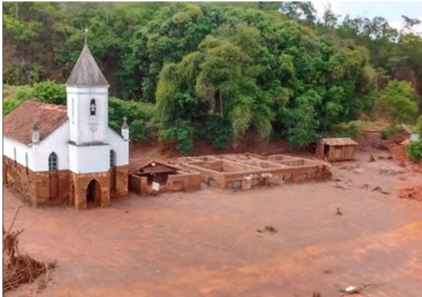
Ilustração 4: Nível da lama e destruição no Distrito de Barra Longa.
