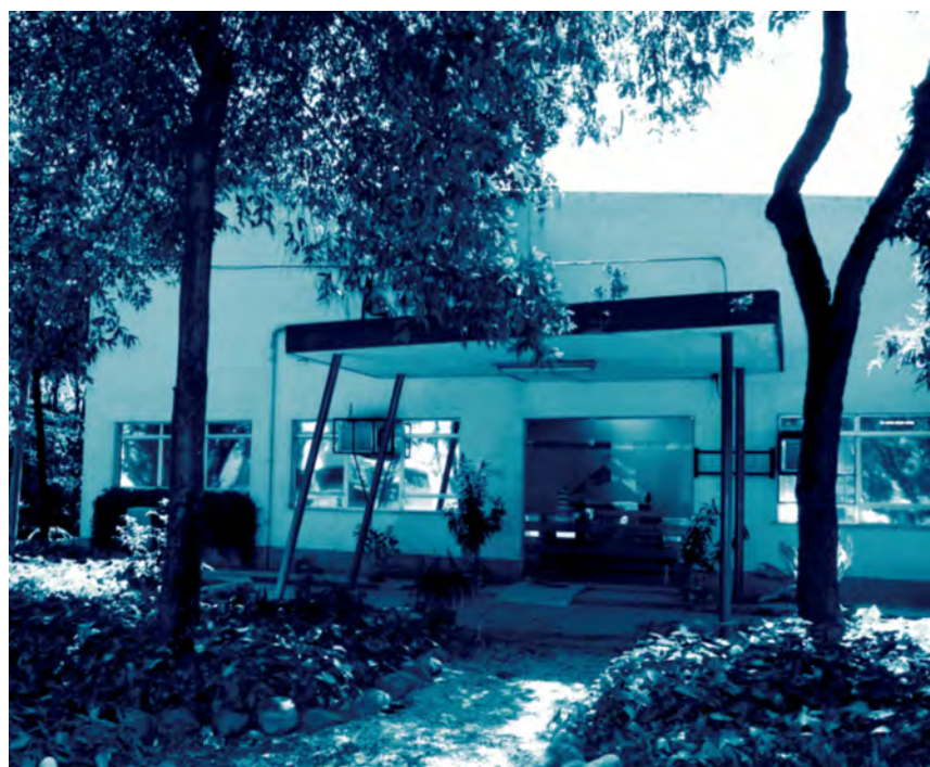
Fachada principal do prédio sede do Departamento de Múltiplos Meios - Fiocruz
