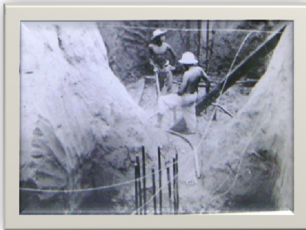
Pilares para um tanque elevado, em Marabá –AM.
