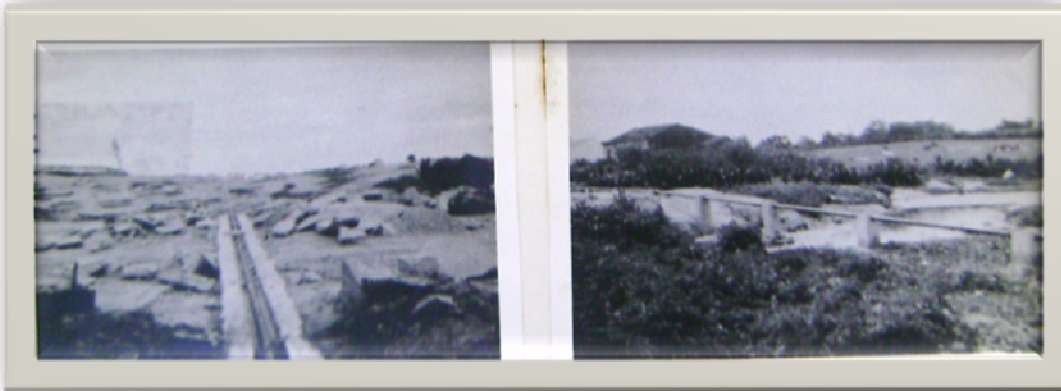
Adutora sobre lago de pedras e sobre pilastras, Esperança - PB
