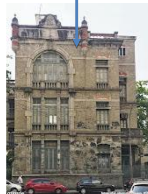
Figura 25: Antiga sede da Diretoria Geral de Saúde Pública DGSP, atual COAGE/INCA Fonte: IRPH / mar. 2012.
