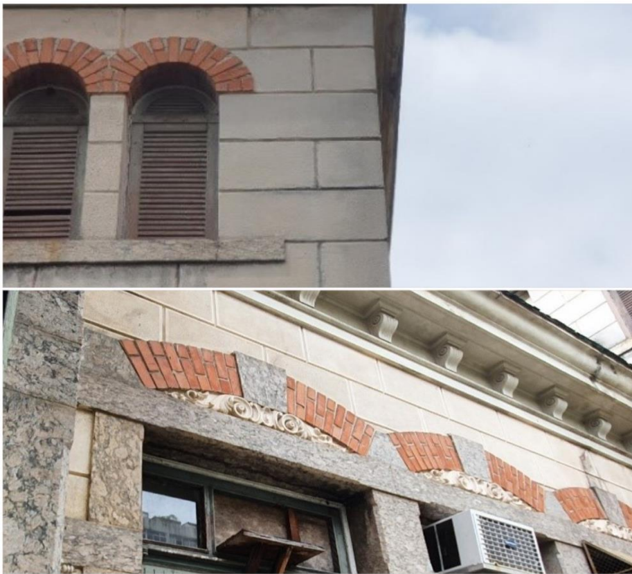
Figura 44: Vergas circular decorada com tijolo de Marselha e verga semi- circular em tijolo de Marselha com granito e ornato de estuque Fonte: A autora, 2022
