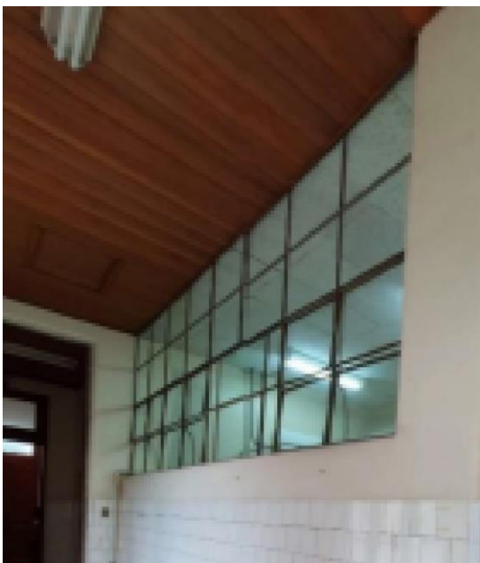
Figura 65: Basculante em ferro fundido com fechamento em vidro Fonte: A autora, 2022.
