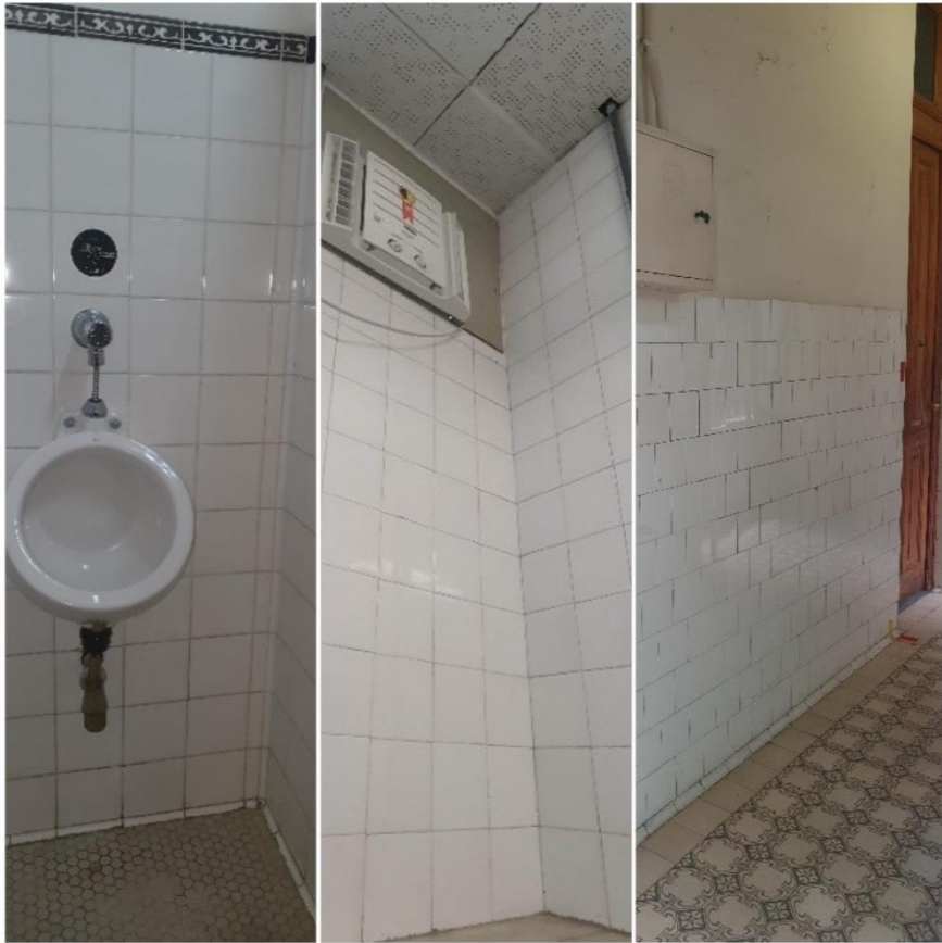
Figura 42: Revestimento em azulejos brancos nos banheiros, copas e com pintura lisa circulações. Fonte: A autora, 2022.
