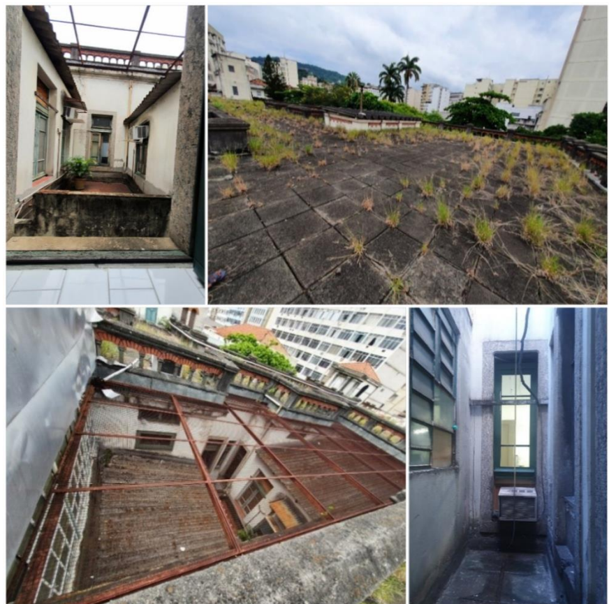
Figura 69: Terraços, prismas e coberturas dos ambientes anexos presentes no prisma principal em telhas de fibrocimento. Fonte: A autora, 2022.
