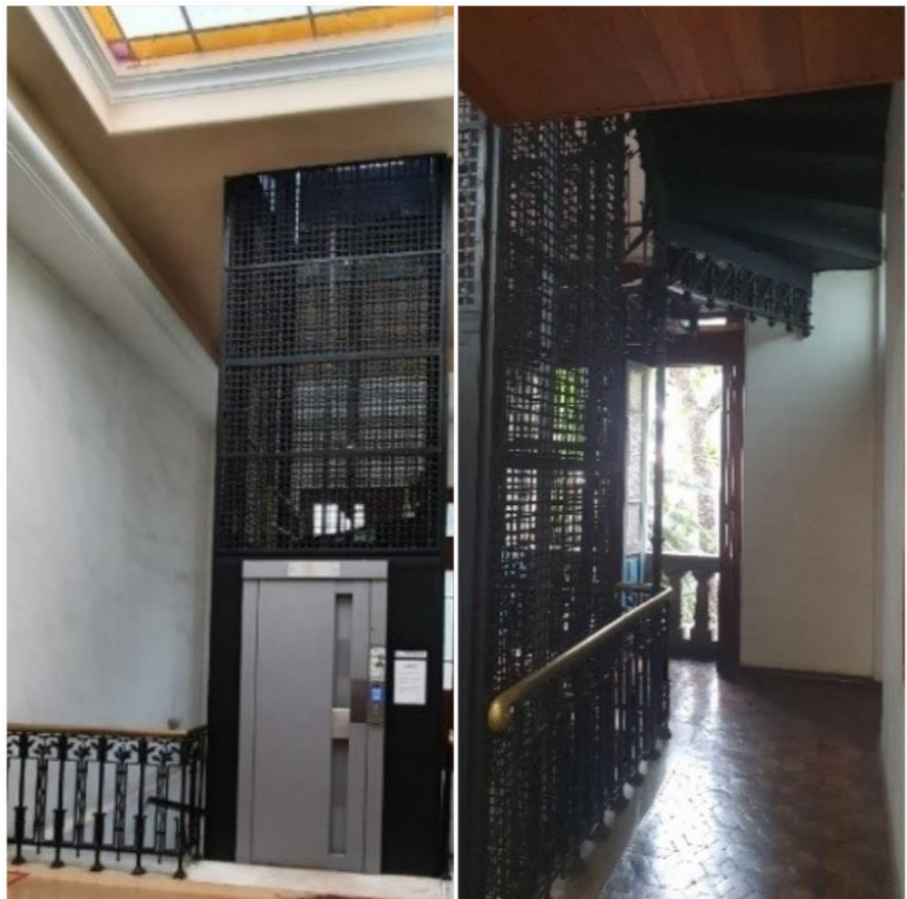
Figura 40: Gradis e corrimãos das escadas e caixa dos elevadores em ferro fundido. Fonte: A autora, 2022
