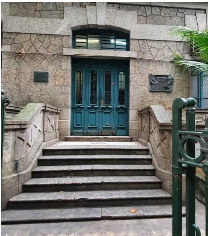
Figura 71: Escada de acesso em granito. Fonte: A autora, 2021.
