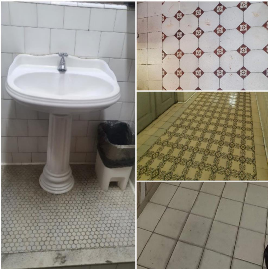
Figura 53: Pisos em pastilhas hexagonais e ladrilho hidráulico existentes nos sanitários, copas e circulações principais. Fonte: A autora, 2022.
