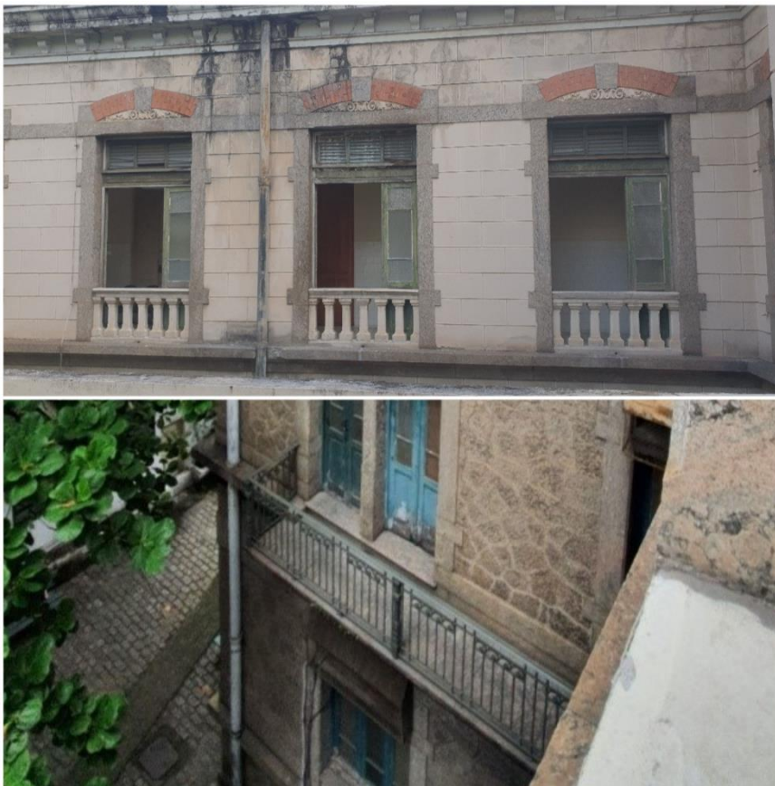
Figura 46: Balastrada em argamassa nos balcões e gradis de ferro fundido nas sacadas. Fonte: A autora, 2022
