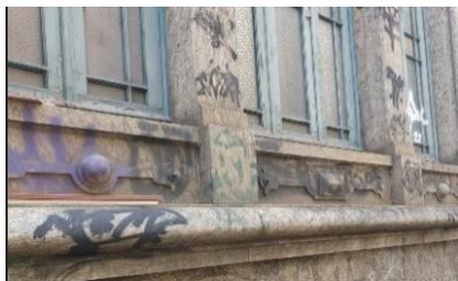
Figura 99: Apodrecimento de peças de madeira e pixações Fonte: A autora, 2022.
