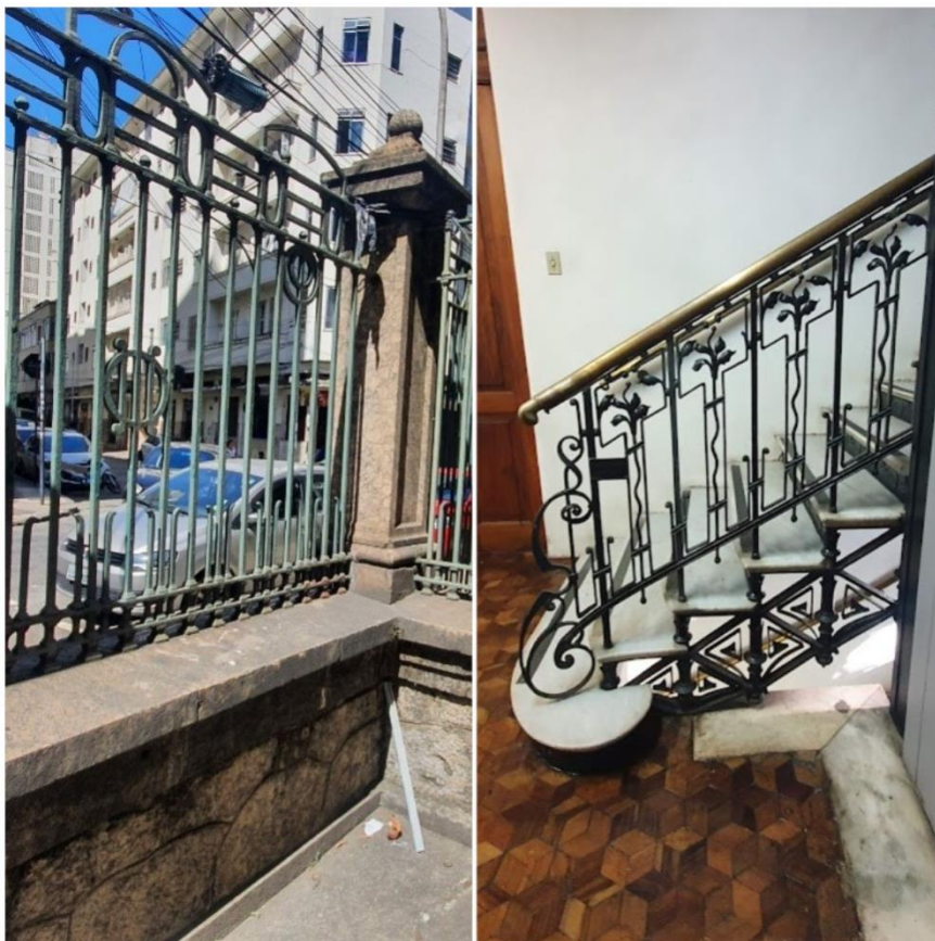
Figura 47: Grades dos muros e gradil das escadas em ferro fundido com estampas Fonte: A autora, 2022
