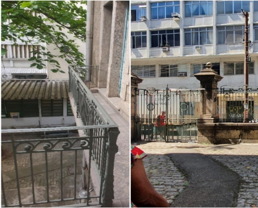
Figura 39: Grades dos portões, muros e sacadas em ferro fundido. Fonte: A autora, 2021
