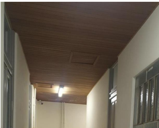
Figura 57: Forro tabuado em madeira, na circulação. Fonte: A autora, 2022.
