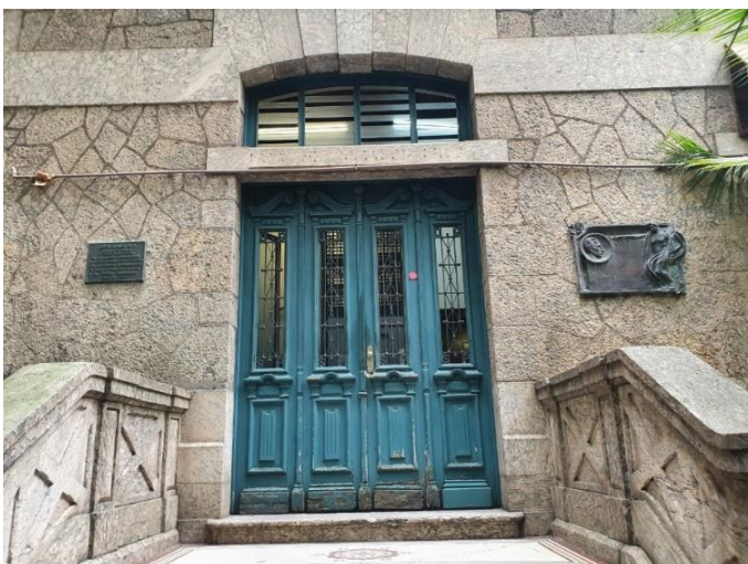
Figura 61: Porta de acesso com caixilhos em fechamento e venezianas em vidro e grades de ferro fundido. Fonte: A autora, 2022.
