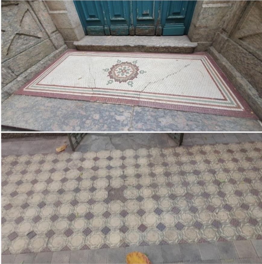
Figura 52: Pisos em mosaico de pastilhas hexagonais e ladrilho hidráulico existentes nos acessos. Fonte: A autora, 2022.
