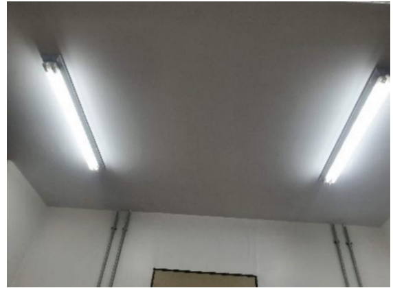
Figura 60: Forro em gesso acartonado. Fonte: A autora, 2022.
