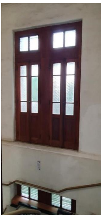
Figura 67: Janelas em madeira com fechamento em vidro e Esquadria em madeira com fechamento em venezianas de vidro, presentes em uma das empenas da escada a permitindo a entrada de luz natural. Fonte: A autora, 2022.
