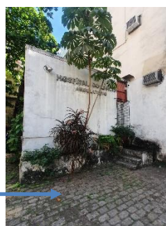
Figura 75: Bloco G – Triagem situado no complexo do DGSP. Fonte: A autora, 2022.
