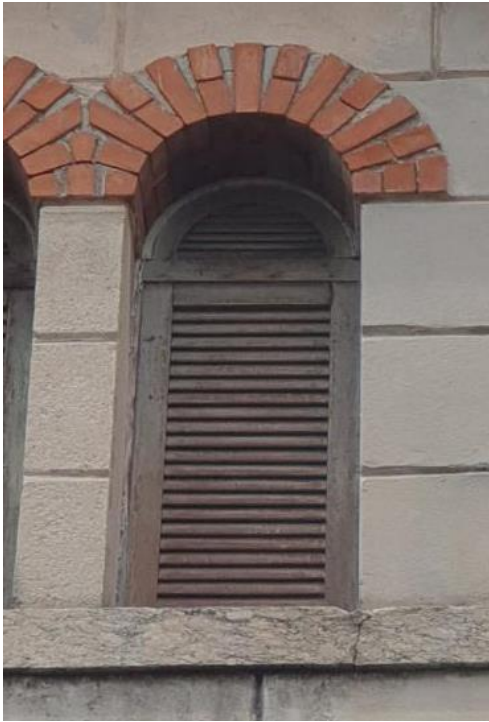
Figura 63: Janela em madeira com fechamento em venezianas. Fonte: A autora, 2022.
