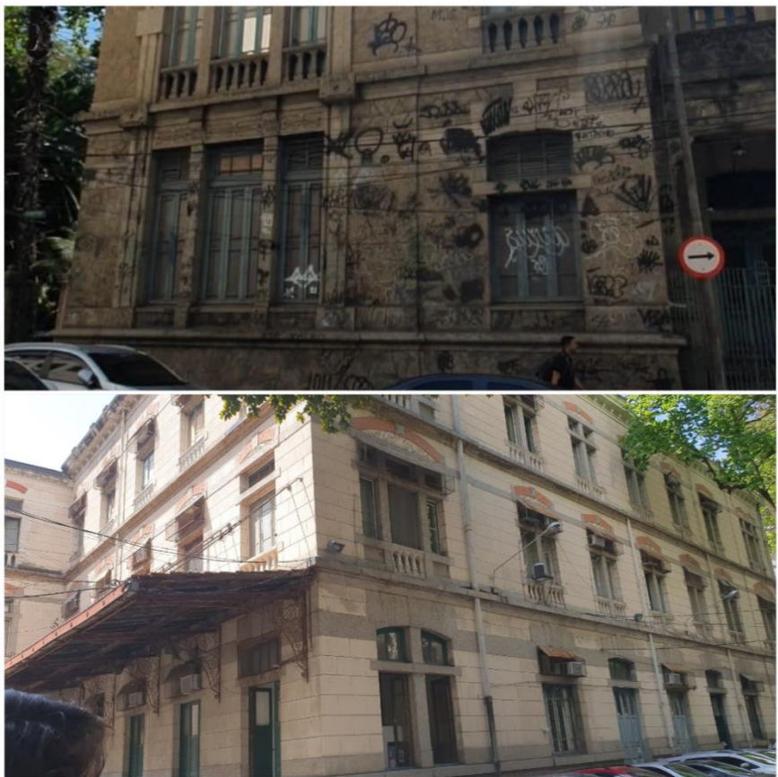
Figura 43: Revestimento em pedra de cantaria na fachada principal, e o mesmo material no embasamento com argamassa nas fachadas laterais e fundos. Fonte: A autora, 2021.
