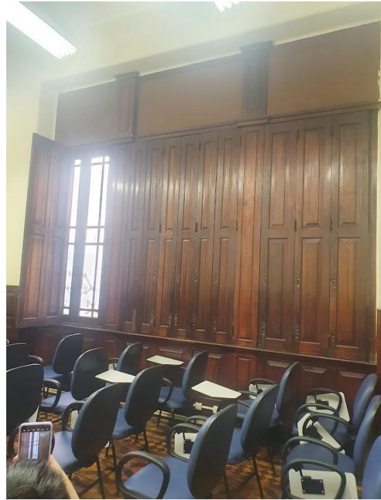
Figura 64: Janelas em madeira com fechamento em vidro, madeira e grades de ferro fundido. Fonte: A autora, 2022.
