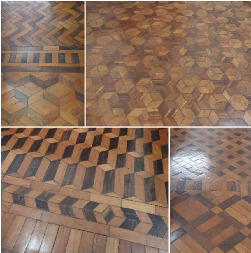
Figura 54: Piso em tacos de madeira tipo parquets motivos diversos, mosaicos com e sem tabeira. Fonte: A autora, 2022.
