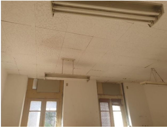
Figura 59: Forro em placas de Compensado Perfurado. Fonte: A autora, 2022.
