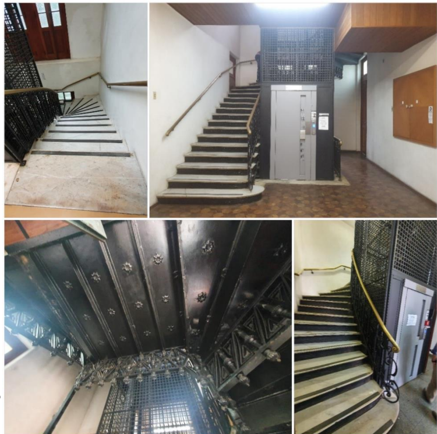
Figura 73: Escada interna principal, em estrutura de ferro fundido e degraus em mármore, permitindo o acesso aos pavimentos. Fonte: A autora, 2022.
