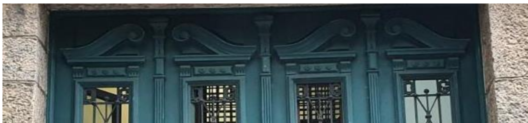
Figura 48: Porta com grades em ferro fundido personalizadas com as letras D e G (Diretoria Geral) Fonte: A autora, 2021.
