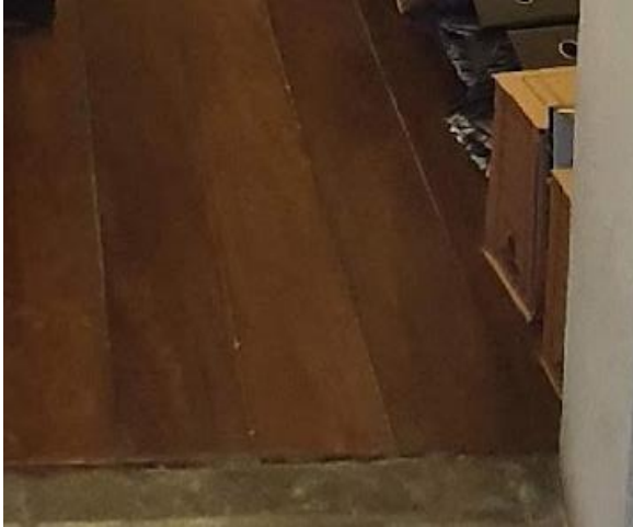
Figura 56: Piso em tabuado corrido de madeira. Fonte: A autora, 2022.
