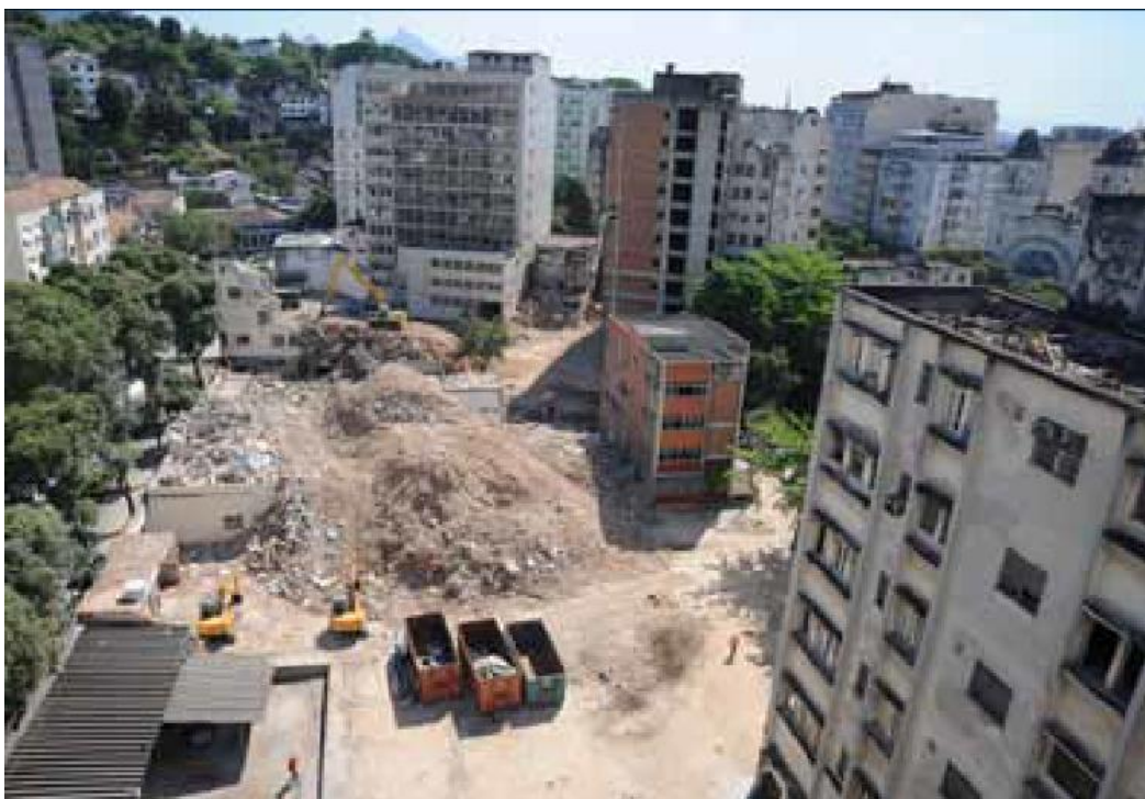
Figura 35: demolição do antigo IASERJ Fonte: Rede Câncer, 2012
