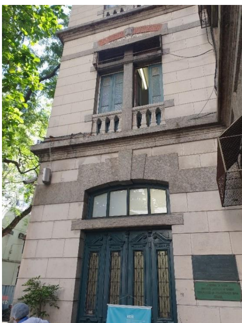
Figura 37: Sobrevergas em granito e em tijolos de Marselha Fonte: A autora, 2021
