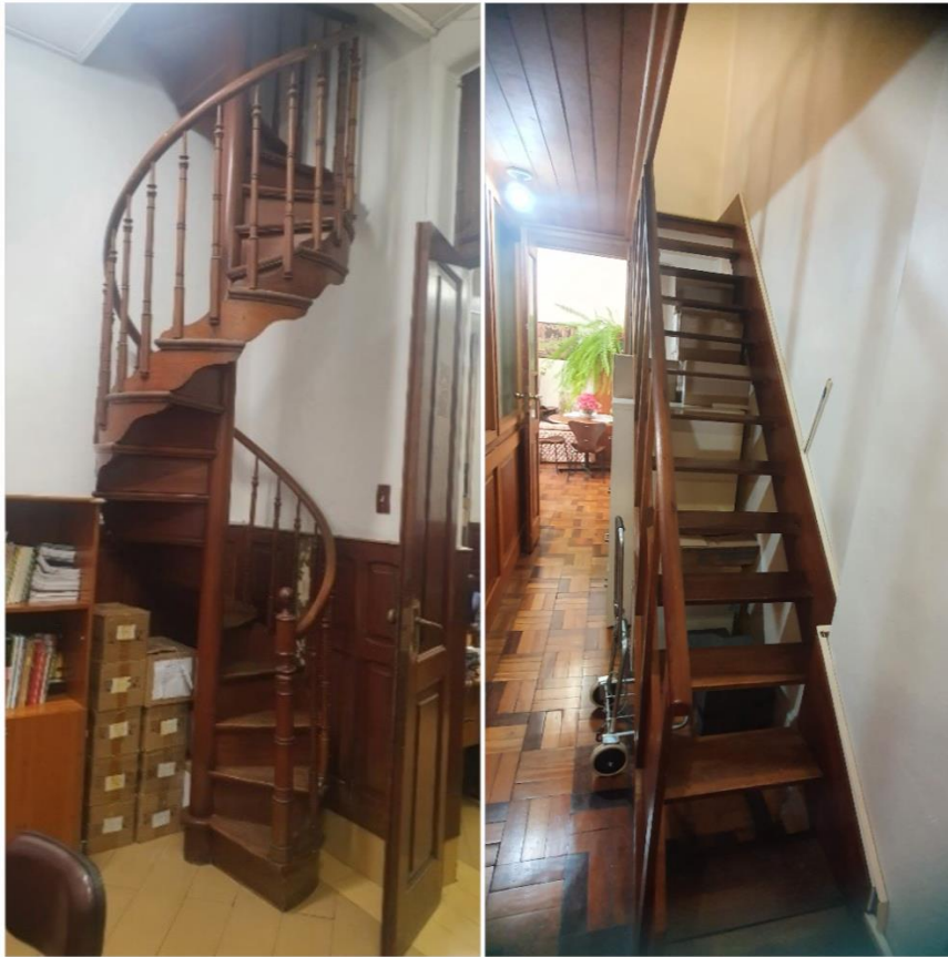
Figura 72: Escadas internas em madeira de acesso aos mezaninos. Fonte: A autora, 2022.
