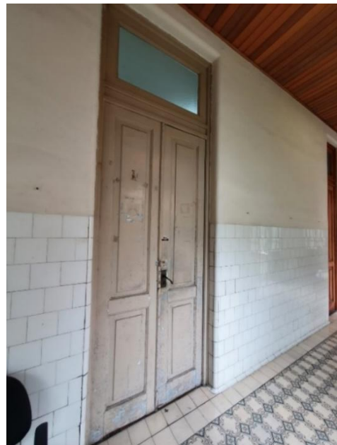
Figura 66: Porta de acesso as salas, em madeira com fechamento da bandeira em vidro. Fonte: A autora, 2022.
