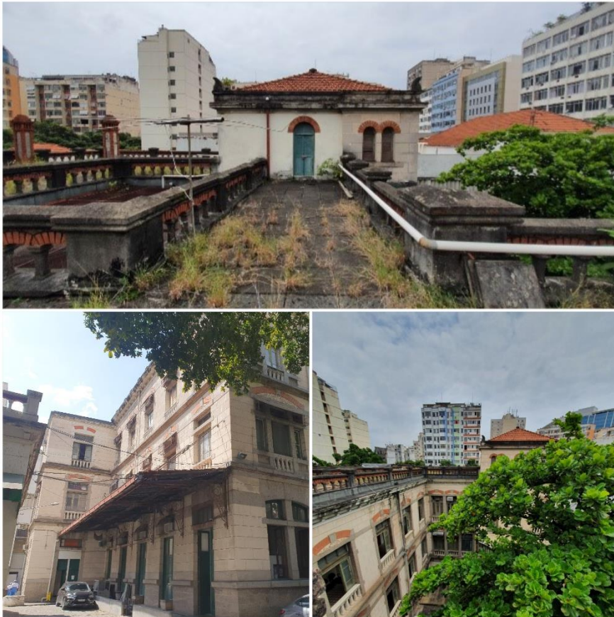
Figura 68: Coberturas dos ambientes presentes no terraço principal em telhas tipo Marselha, o mesmo material da cobertura aparente do pavimento térreo. Fonte: A autora, 2022.
