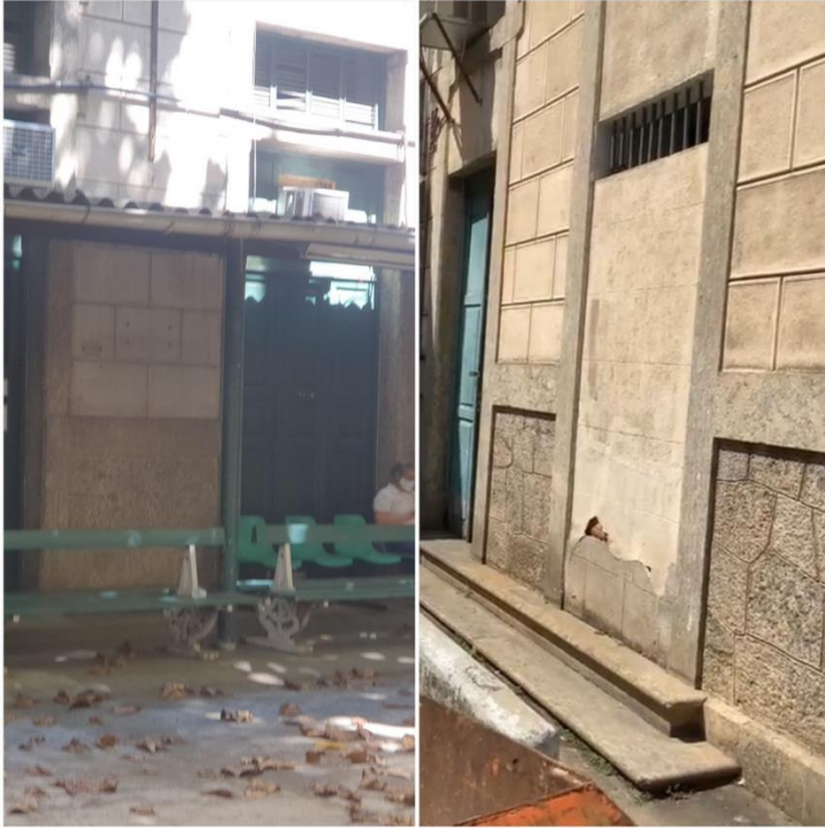
Figura 79: Portas de acesso fechadas temporariamente e permanentemente Fonte: A autora, 2022.
