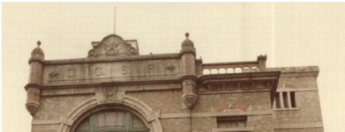
Figura 33: Frontão da fachada principal do edifício sede da Diretoria Geral de Saúde Pública antigo Centro Municipal de Saúde Oswaldo Cruz: Rio de Janeiro (RJ). Fonte: Fotógrafo João Carlos Parreiras Horta, 1983.
