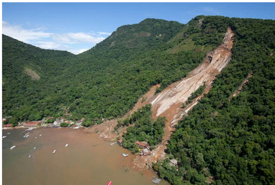
Figura 3.4: Área de deslizamento de encosta na Ilha Grande, janeiro de 2011. Fonte: http://www.abril.com.br/imagem/deslizamento-angra-dos-reis-01g.jpg
