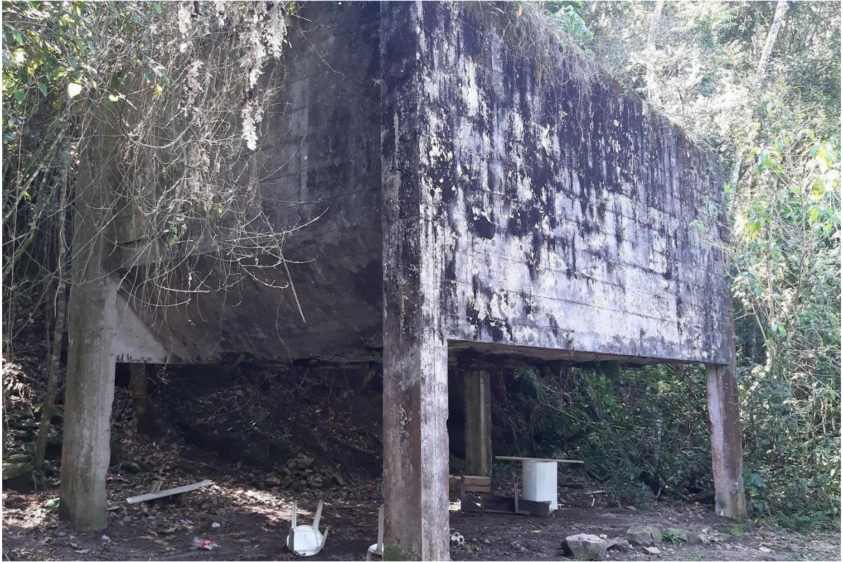
Figura 24 – Resquícios de um armazenador de pedras, próximo a trilha de acesso para a pedreira. Fonte: Acervo pessoal da autora (2021)
