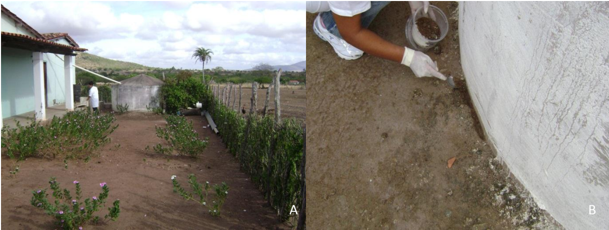
Figura 08: Foto da caixa d'água (A). Amostragem em uma fenda ao redor da caixa d'água. Fonte: José Carlos Miranda.
