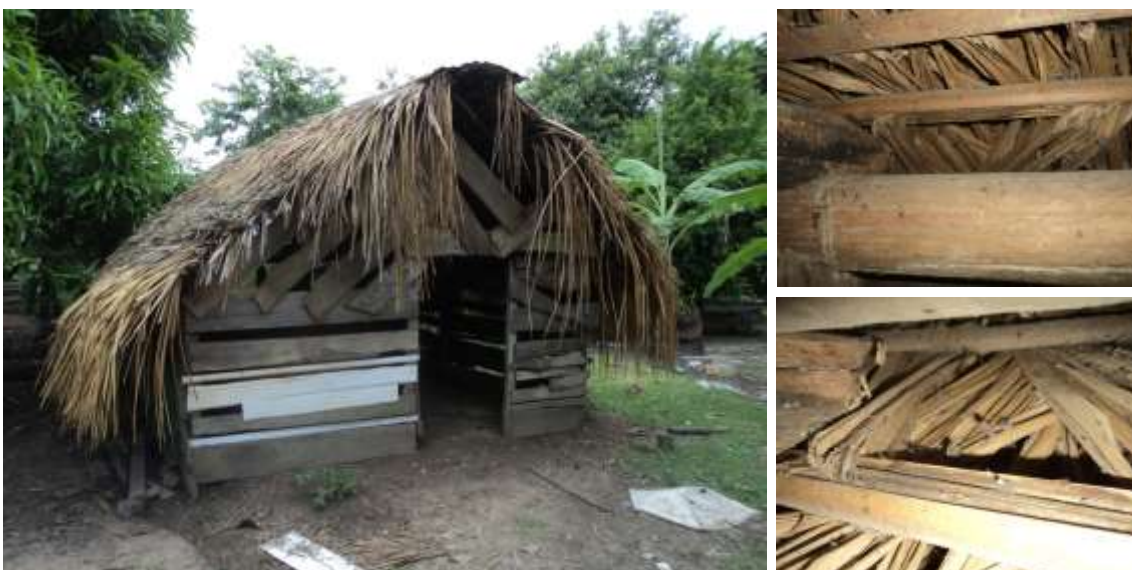
Figura 20: Galinheiro fechado com cobertura de palha de inajá. No detalhe, parte interior da cobertura de palha com vestígios de triatomíneos, como exúvias e fezes (setas). Município de Amajari, março de 2015.
