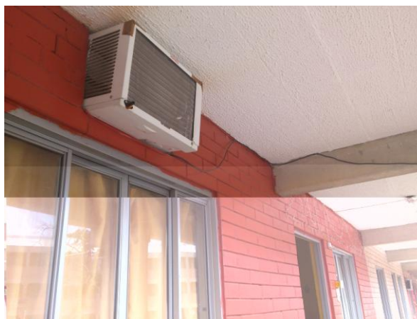
Figura 14 – Localização do aparelho condicionador de ar instalados na sala de um dos apartamentos do DSUP, Complexo de Manguinhos, RJ.
