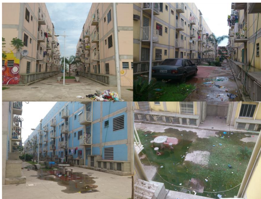
Figura 11 – Área dos fundos dos blocos da Comunidade do DSUP, Complexo de Manguinhos, RJ.
