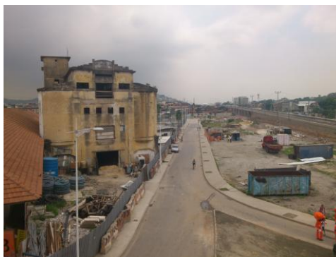
Figura 20 – Vista do canteiro de obras do Programa de Aceleração do Crescimento (PAC) na Comunidade do DSUP, Complexo de Manguinhos, RJ.
