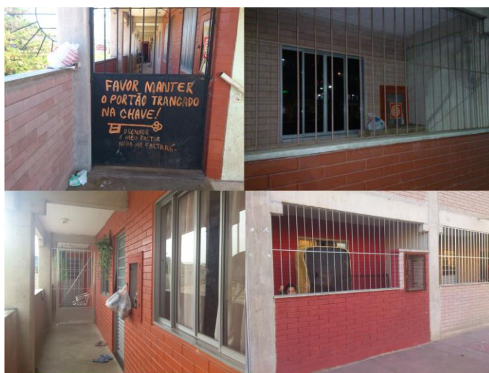
Figura 16 – Gradeamento dos corredores e fechamento das laterais dos corredores do 1º andar dos apartamentos da Comunidade de DSUP, Complexo de Manguinhos, RJ.
