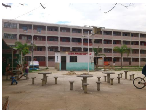
Figura 22 – Construção da sede da Associação dos Moradores do DSUP, Complexo de Manginhos, RJ.
