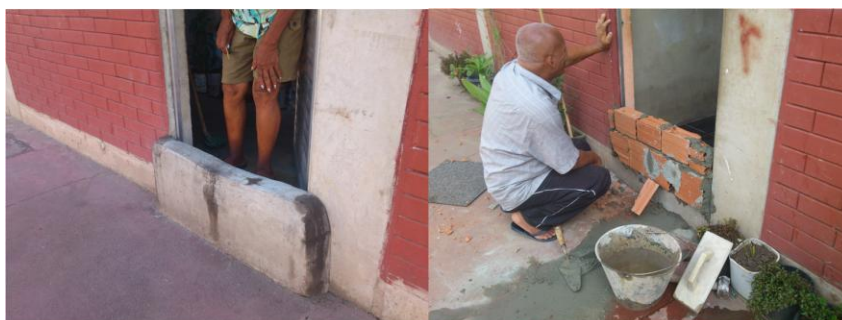
Figura 18 – Barreiras construídas para que as águas das chuvas não entrem nos apartamentos do térreo, Comunidade do DSUP, Complexo de Manguinhos, RJ.
