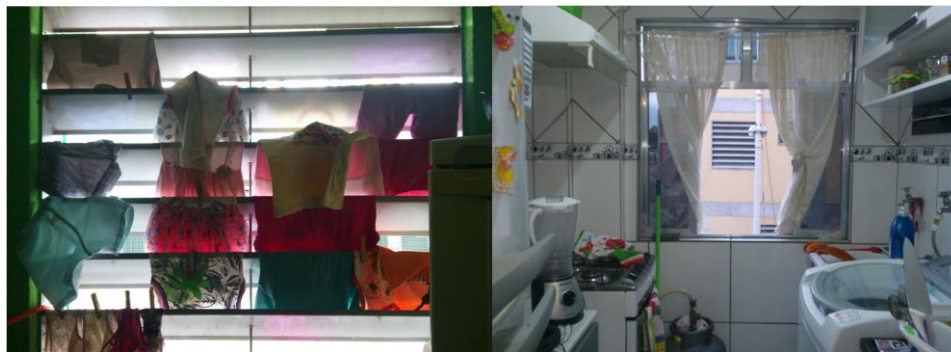
Figura 15 – Uso dos basculantes originais como varal e retirada do basculante original para a instalação de uma janela nos apartamentos da Comunidade do DSUP, Complexo de Manguinhos, RJ.
