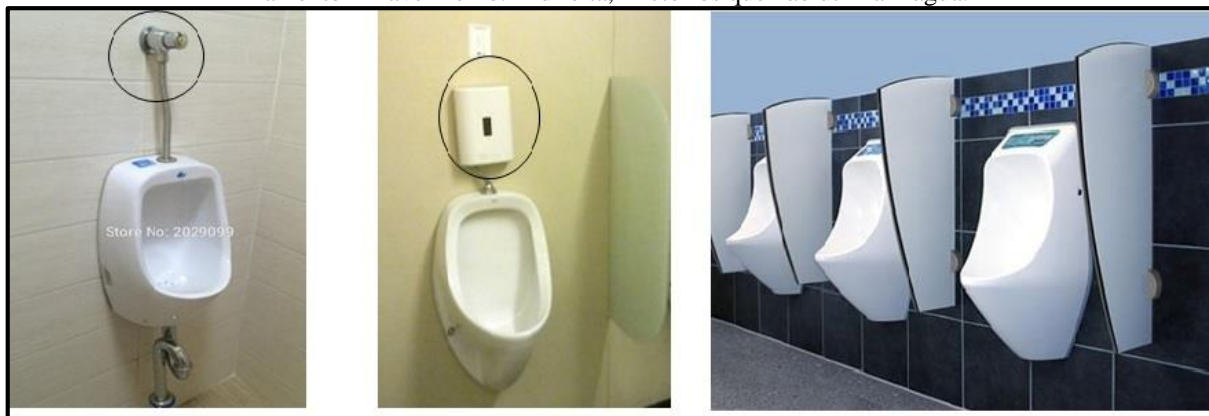
Figura 47: Tipos de mictórios. À esquerda, com válvula de fechamento automático. Ao centro, válvula com acionamento infravermelho. À direita, mictórios que não utilizam água.
