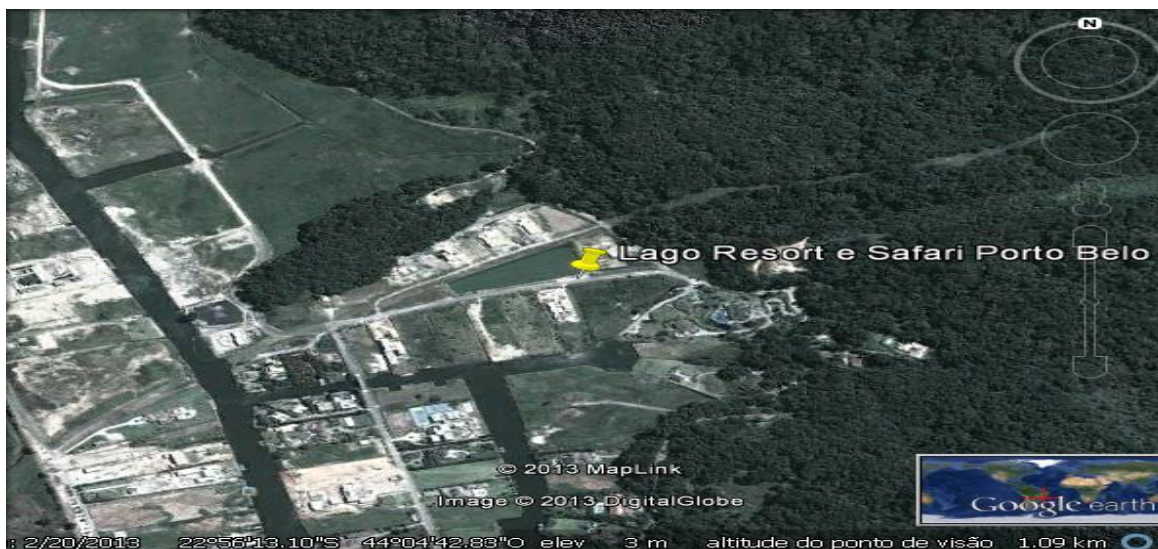
Fig. 18 – Foto aérea do Resort Safári Porto Belo – Conceição de Jacaref – Foto Google earth 2013.
