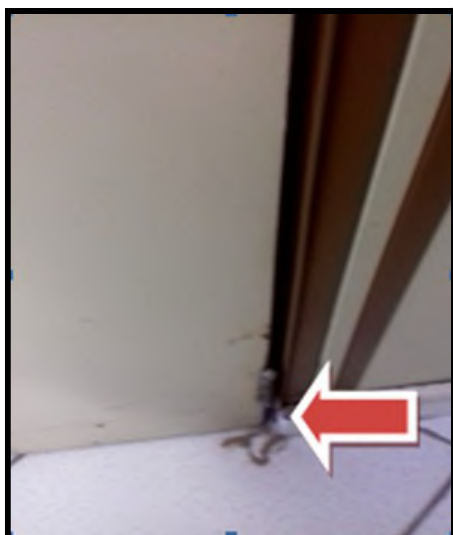
Figura 17 – Ataque de cupim na porta da circulação
