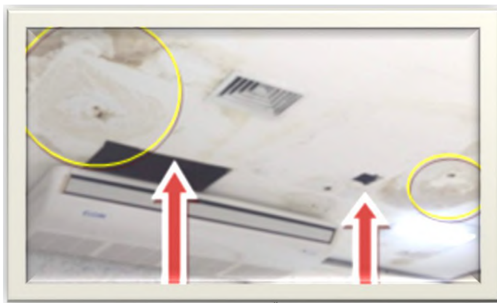
Figura 22 – Infiltrações e buracos no ACG
